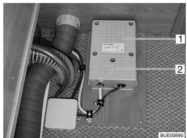
Fig. 122 Transformateur du chauffage électrique du plancher
